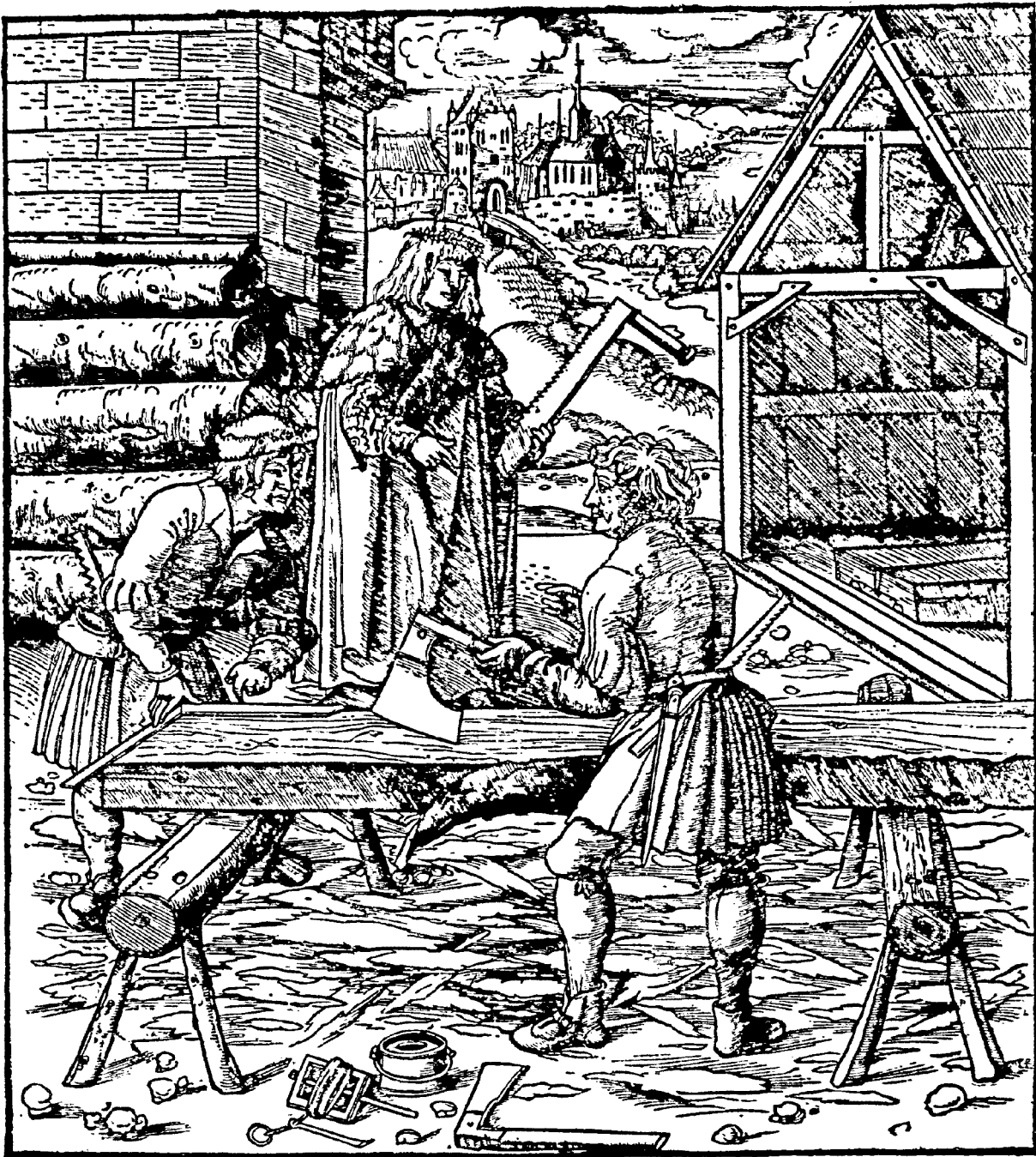
Abb. 27. Zimmerleute bei der Arbeit, im Hintergrund Kaiser Maximilian. Holzschnitt von Hans Schäußlein (?) (ca. 1492—1540) aus dem Weiskünig. Muther S. 124, 21.
